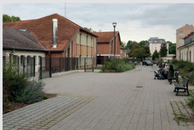
École élémentaire du Ziegelwasser de Strasbourg
