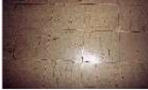
Dalles de sol
