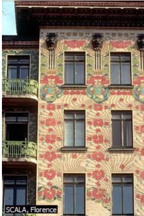
Détail de la façade, O. WAGNER? Majolikahaus, Vienne, 1899
